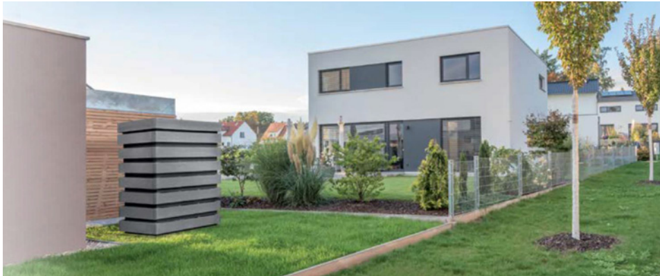
Fot. 2. Osłona akustyczna agregatu pompy ciepła.
