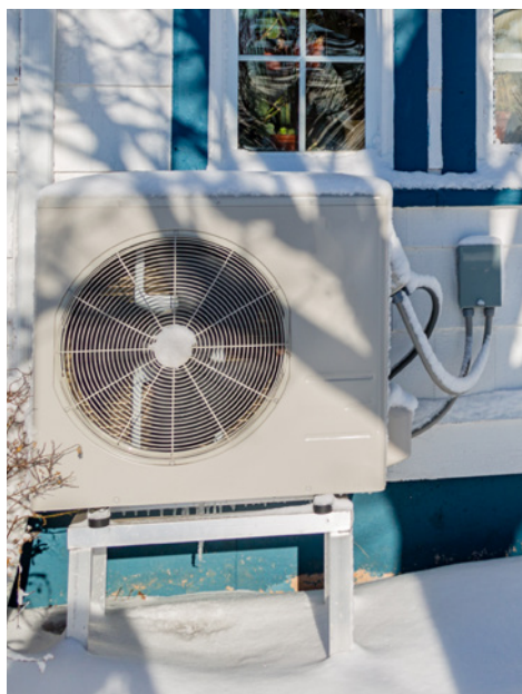
Fot. 1. Posadowienie pomp ciepła na konstrukcji wsporczej na gruncie: a) metalowej prefabrykowanej, b) betonowej.
