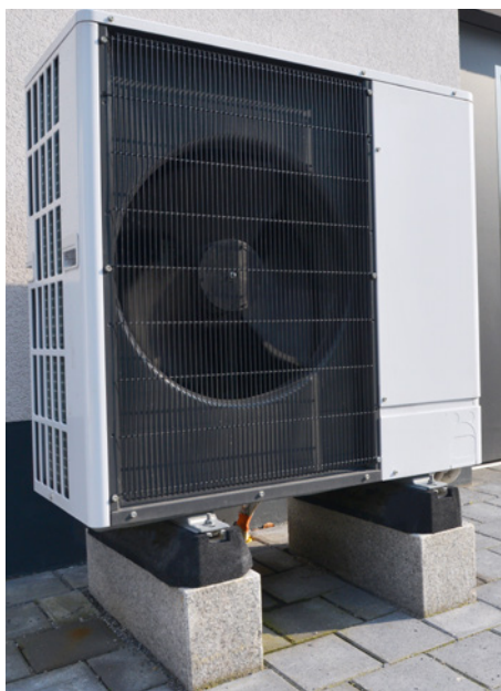
Fot. 1. Posadowienie pomp ciepła na konstrukcji wsporczej na gruncie: a) metalowej prefabrykowanej, b) betonowej.
