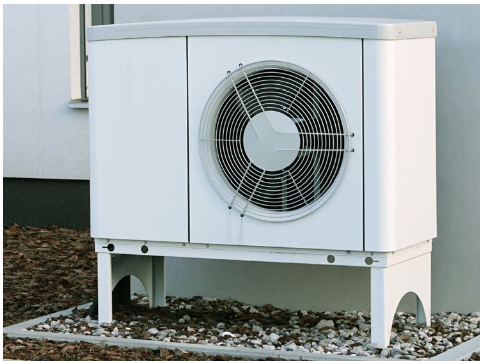
Fot. 2. Pompa ciepła na podłożu żwirowym umożliwiającym skuteczne odprowadzenie skroplin.
